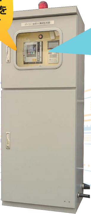
左は水質連続測定装置外観、右の表示器には連続監視データのグラフを表示されています。
